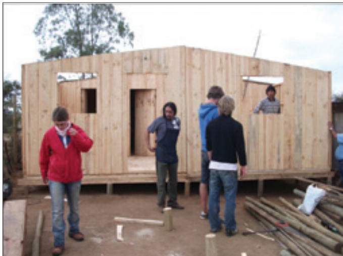
Einsatz im Erdbebengebiet im Süden Chiles: Errichtung mehrerer kleiner Holzhäuser, wobei auch deutsche Freiwillige mitwirkten.
