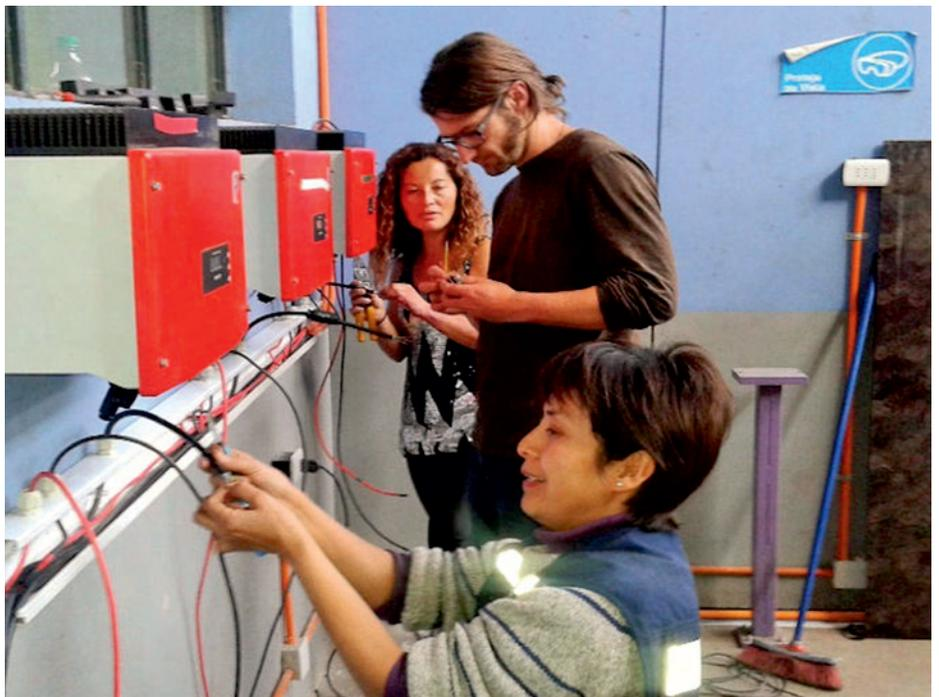
*Frauen des ersten staatlichen Förder-Kurses Ausbildung Fotovoltaik-Installateurin beim Anschließen der SMA-Wechselrichter für die 4-KWp-Pilotanlage im November 2015, noch mit RPS-Ing. Sebastian Bayer als Firmen-Berater von Kraftwerk Power Solution (Heute GIZ-CIM Fachkraft bei FCV).*
