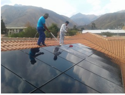
Wartung, Reinigung Fotovoltaik-Anlage
