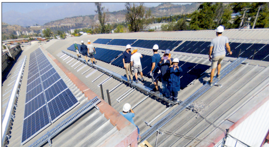
Besichtigung der Solarmodule auf dem Dach der Berufsschule EFPO
