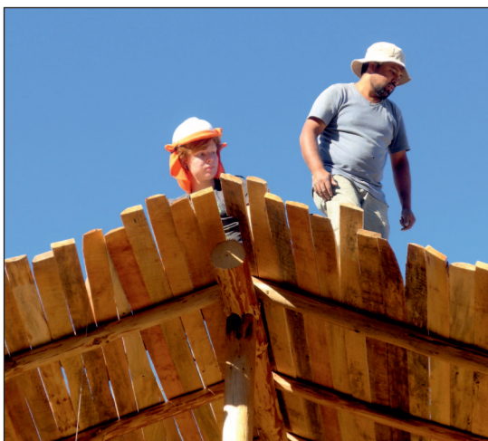
Das Dach muss schnell fertig werden
